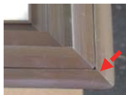
アルミ枠の縁(エッジ)が剥き出し
